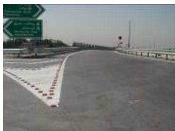
شکل ۵- مکانهای نیازمند نصب ضربه گیر و یا ضربه گیر بدون طراحی مناسب
