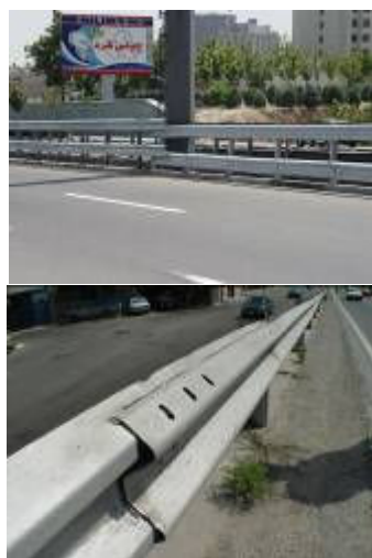
شکل ۳- مکانهای دارای حفاظ کناری همراه با نواقص در جاده‌های درون شهری و برون شهری
