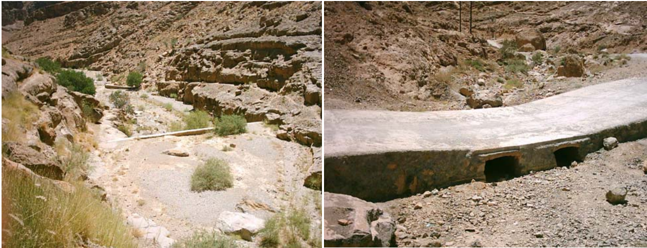
شکل ۱۵. کف بند تحلیل شده در رودخانه دره گاهان
