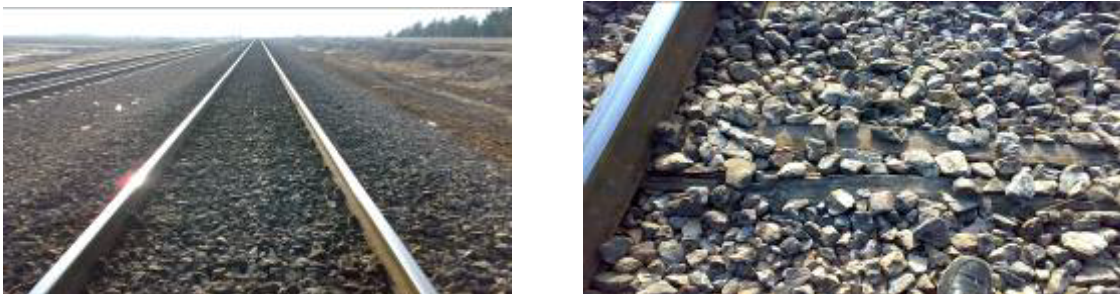
شکل ۴- انباشتگی بالاست بین دو ریل
