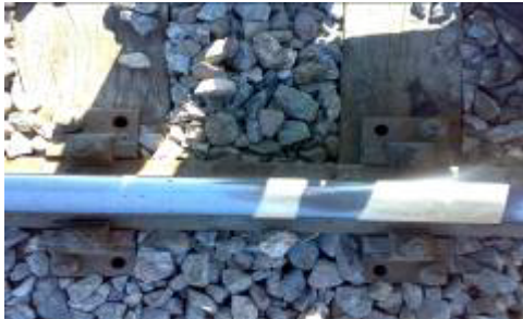
شکل ۶- کمبود پیچ در اتصال ریل به تراورس
