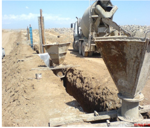
شکل ۴ - بتن ریزی بوسیله قیف و لوله ترمی فلزی
