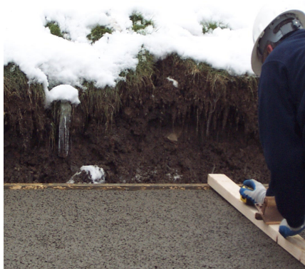
شکل ۳ - پرداخت سطح بتن متخلخل
