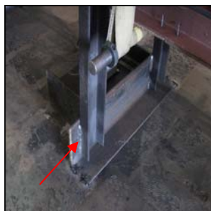
شکل شماره ۱۰: اتصال جوشی بادبندهای افقی بین خریاها و تکیه گاه
