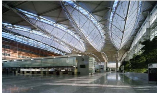
شکل ۱۱- ترمینال بین المللی سافرانسیسکو- پس از عملیات نصب جداگرهای لرزه ای
