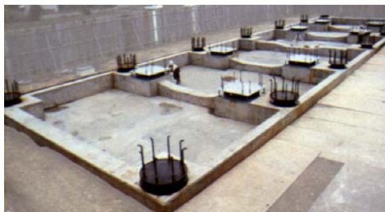
شکل ۲- نمونه ای از فونداسیون به همراه جداگر های لرزه ای نصب شده در محل اتصال به ستون
