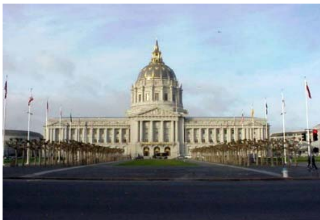
شکل ۹- ساختمان city hall در سانفرانسیسکو تقویت شده با جداگرهای لرزه ای
