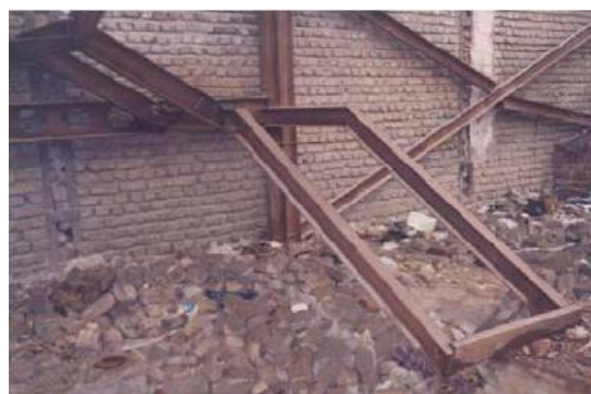
شکل ۱۲- کج شدن مقطع عرضی راه پله به علت تفاوت طول دو تیر شمشیری
