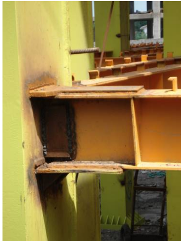
شکل ۵- ورق به صورت دوزنقه ای در محل اتصال به ستون
