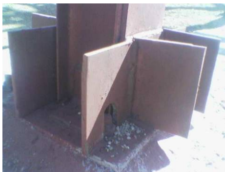
شکل ۱- اتصال نامناسب ستون به صفحه ستون
