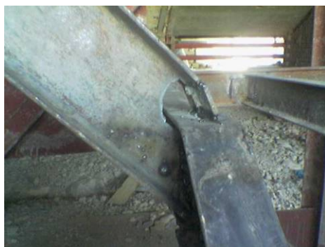
شکل ۱۱- اتصال نادرست شمشیری
