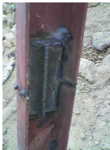
شکل ۳- وصله نامناسب
