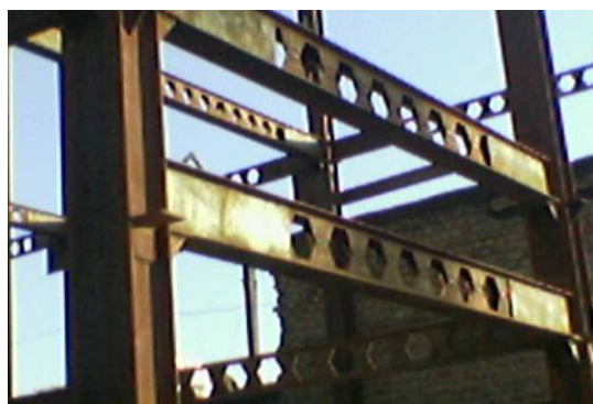
شکل ۴- استفاده از تیر آهن لانه زنبوری در سیستم قاب خمشی
