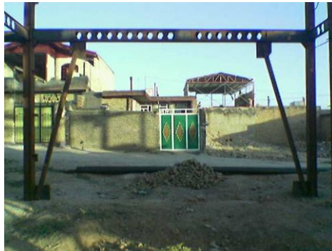
شکل ۹- زاویه زیاد مهاربند واگرا با افق
