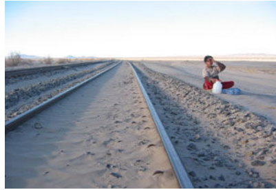
شکل (۷) - نمونه ای از نفوذ مواد خارجی به بالاست و کثیفی آن [۱۰]
