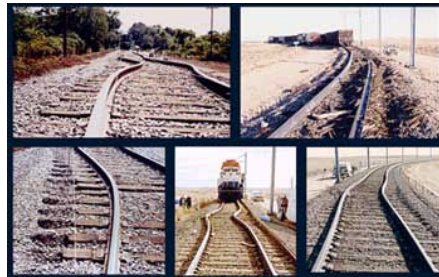
شکل (۱) - کمانش جانبی خط آهن [۱۱]
