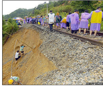
شکل (۲) - نشست لایه زیر سازی و در نتیجه نشست بالاست و خرابی خط [۱]
