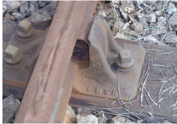
شکل (۳) - نمونه ای از پلیسه شدن سطح غلطش ریل [۹]
