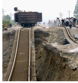
شکل (۲) - نشست لایه زیر سازی و در نتیجه نشست بالاست و خرابی خط [۱]
