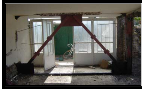
شکل ۱۰- اضافه کردن بادبند ۸ شکل
