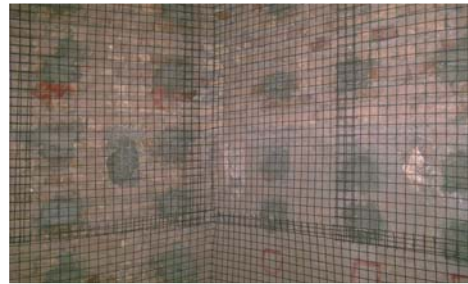
شکل ۱۲- تقویت میانقاب ها با آرماتور.
