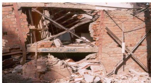
شکل ۷- سقف با صلبیت ناکافی
