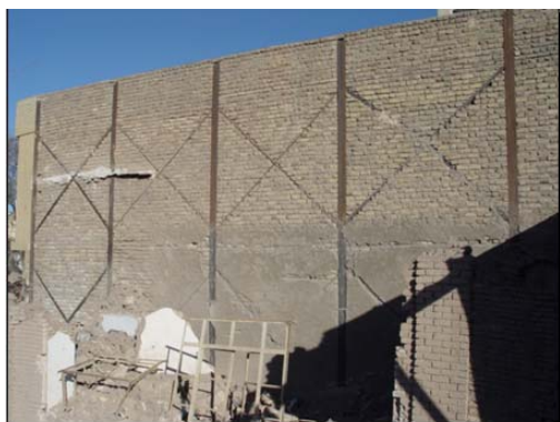
شکل ۹- عملکرد مناسب پرکننده های میان قابی.
