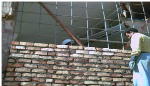
شکل ۱۳- اضافه کردن میانقاب مسطح در قاب خمشی.
