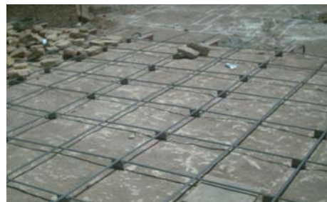
شکل ۱۴- تقویت سقف.
