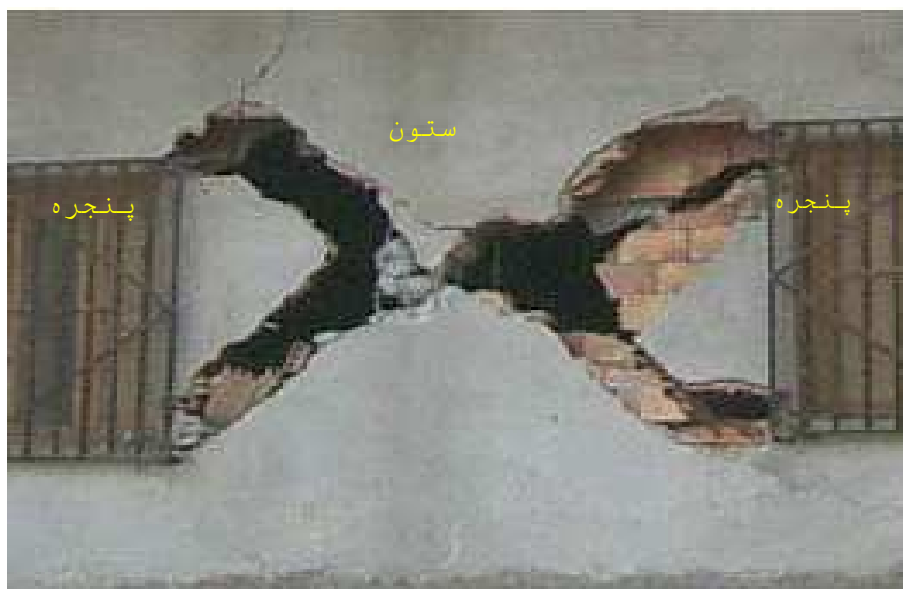
شکل ( 5 ) : آسیب های ایجاد شده توسط پدیده ی ستون کوتاه. به دلیل وجود دو پنجره در اطراف ستون (ترک های X شکل)
