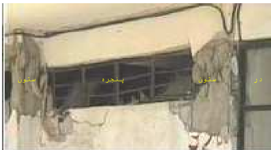
شکل ( 4 ) : آسیب های ایجاد شده توسط پدیده ی ستون کوتاه به دلیل وجود در و پنجره در کنار ستون .
