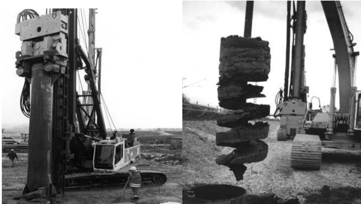
شکل 1- روش اجرای سیستم جابجایی و جایگزینی
