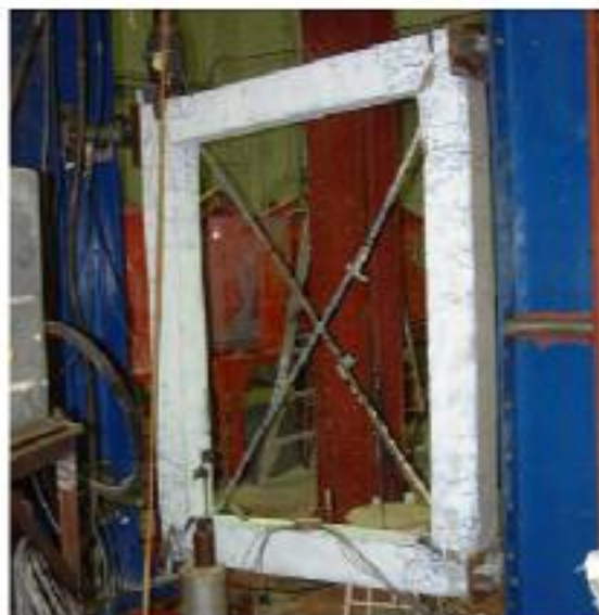
شکل ۷. ترک های مشاهده شده در قاب خمشی در زمان شکست
