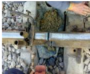
شکل (۵) - بستن فک های نگهدارنده
