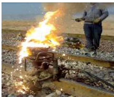
شکل (۸) - مشتعل شدن مواد جوش
