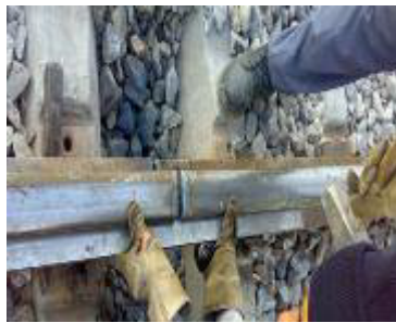
شکل (۴) - تنظیم کردن دو سر ریل
