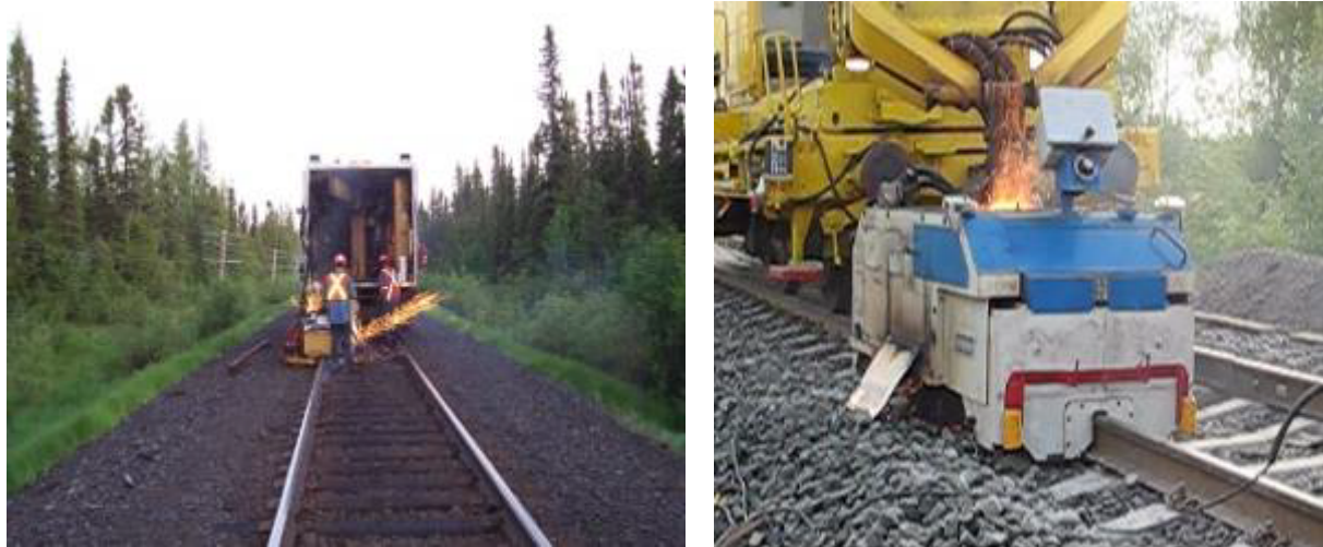
شکل (۱) - نحوه کار ماشین جوش الکتریکی
