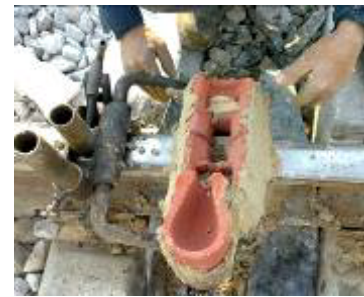
شکل (۶) - نصب قالب در محل
