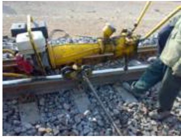
شکل (۱) - باز کردن پیچها
