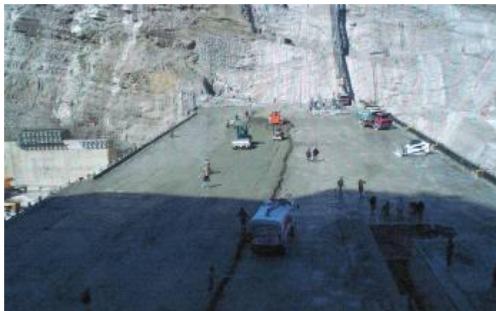
شکل شماره 2- جاگذاری بتن غلطکی
