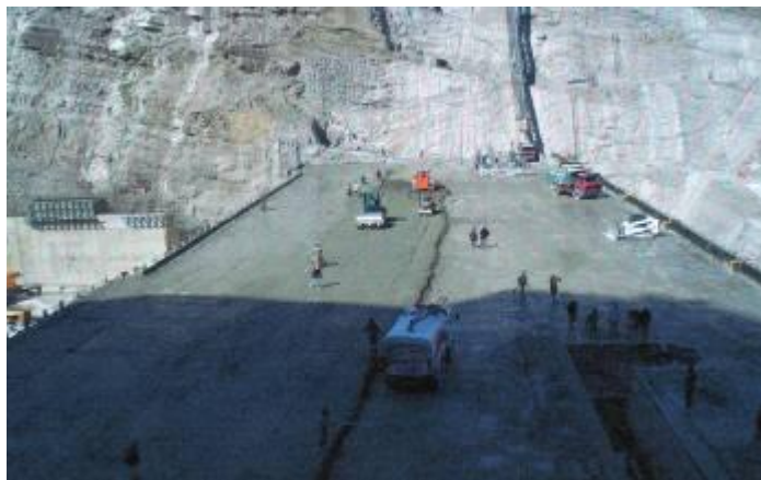
شکل شماره 2- جاگذاری بتن غلطکی
