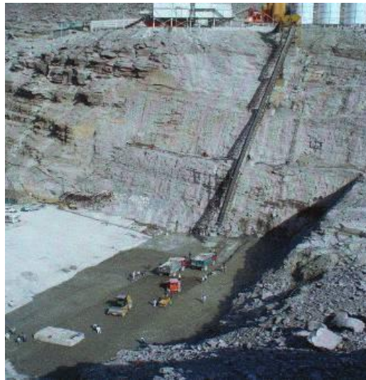
شکل شماره 1- جاگزاری بتن غلطکی و شیوه انتقال آن با استفاده از شوت انتقال
